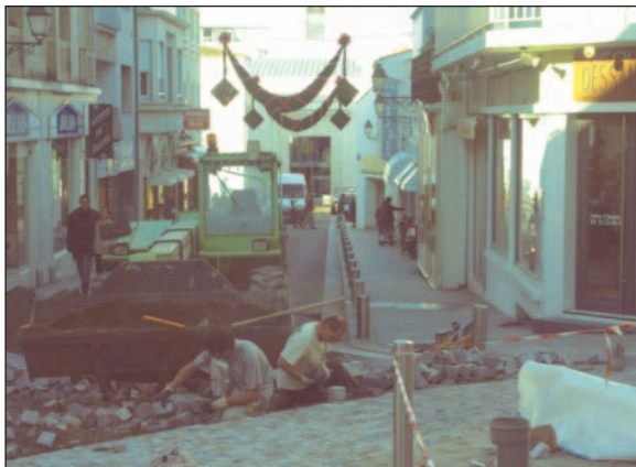
Les services municipaux ont réalisé la pose des pavés.
