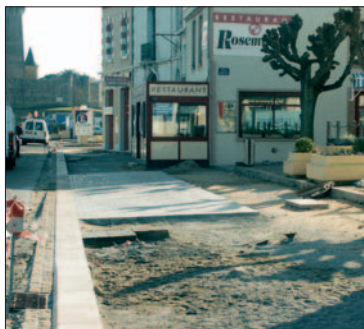
Les ouvriers ont débuté la réalisation du trottoir de plain-pied
