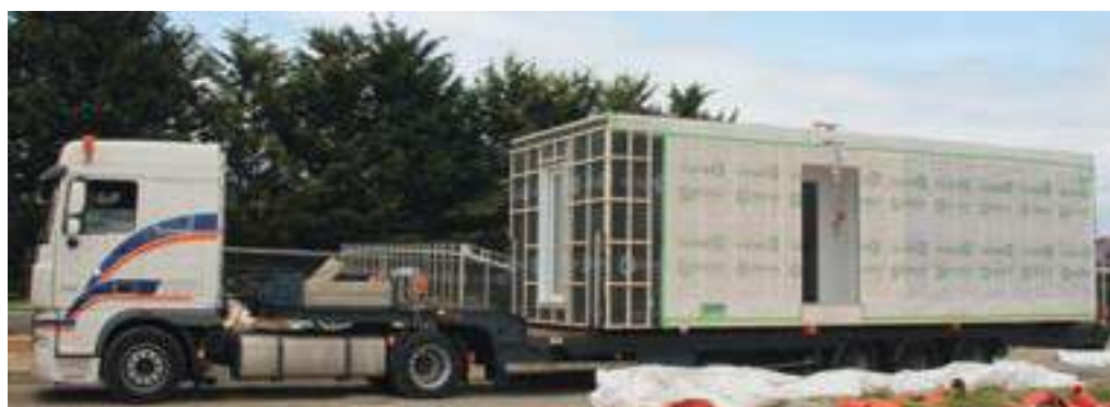
Préfabriquées en usine, à La Chaize-le-Vicomte, les maisons arrivent en camion la dernière semaine d'avril, transportées une à une comme un conteneur.
