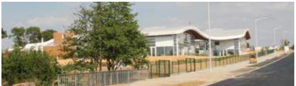
Cette première partie de la rue des Plesses dessert directement le pôle aquatique, et, en face, le centre de loisirs.
