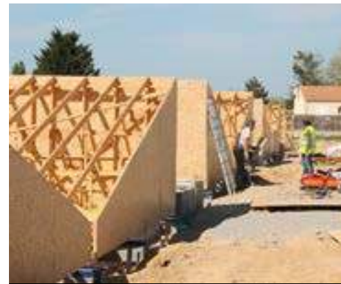
Assemblage préalable au sol des toitures, 2 e quinzaine d'avril.
