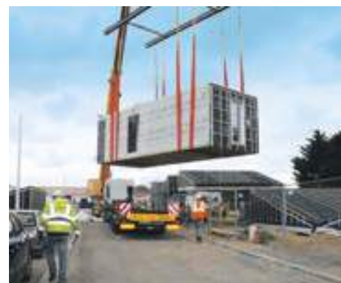
Puis elles sont grutées pour être déposées sur leur dalle béton.
