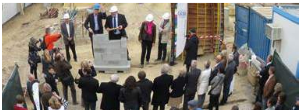
Vendredi 10 avril, la pose de la première pierre, à peine un mois et demi après l'ouverture du chantier.
